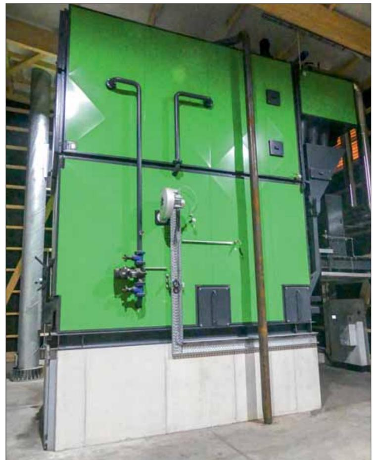
Der neue Holzkessel hat mehr als die doppelte Leistung des Vorgängers. Er versorgt neben zehn Trockenkammern die Produktions- und Büroräume. Der Kessel steht auf einem Betonsockel, der den Aschecontainer aufnimmt. Durch die ebenerdige Aufstellung ist dieser zum (selten nötigen) Leeren leicht zu entnehmen.
