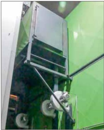
Der Wärmetauscher erhöht den Wirkungsgrad des Kessels deutlich.
