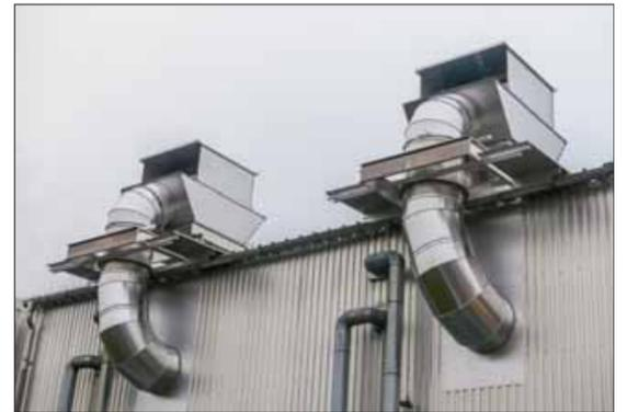
Zwei ältere Kammern wurden mit Wärmerückgewinnungssystemen nachgerüstet und mit frequenzgesteuerten Ventilatoren modernisiert.
